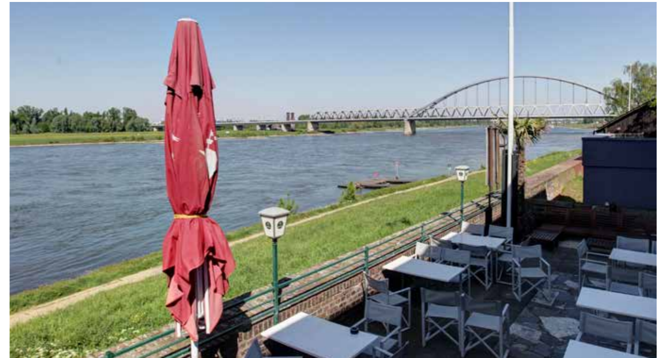
Blick von der Terrasse des Ruderclubs auf die Eisenbahnbrücke
