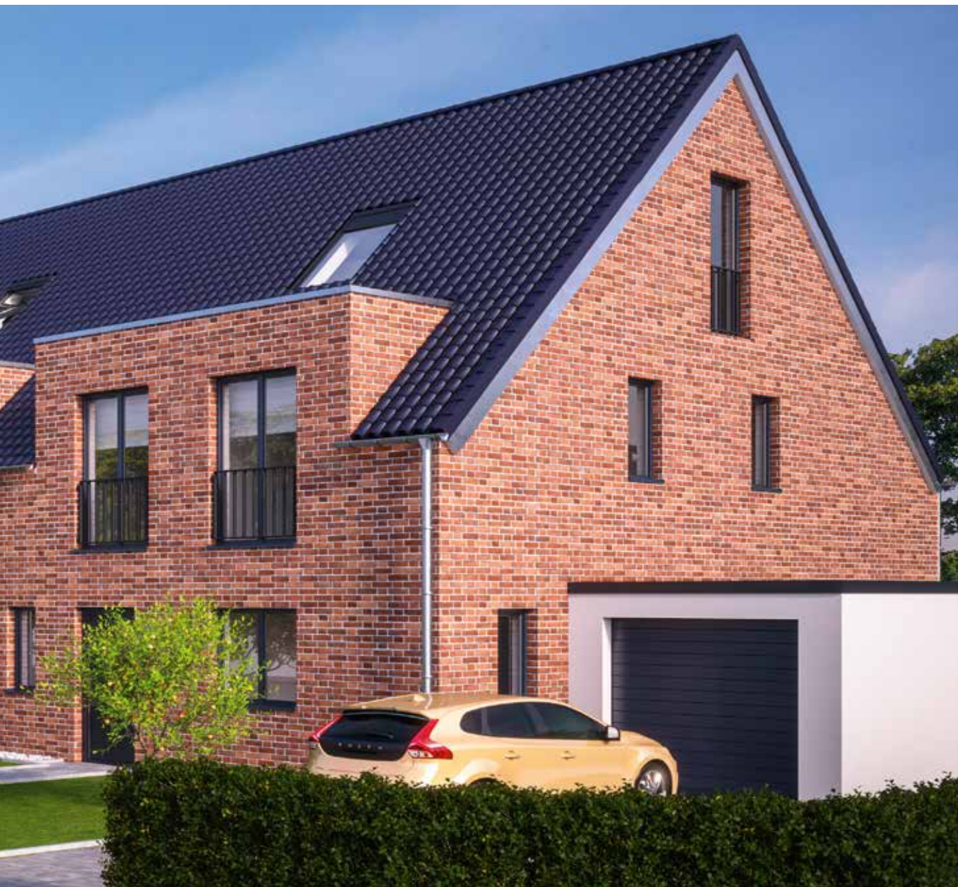
Die Dachdeckung ist geplant mit dem Betondachstein »Harzer Pfanne« von Braas
